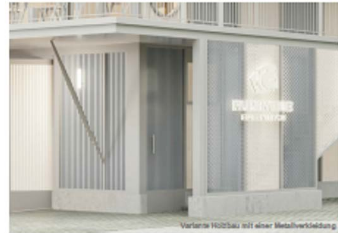
Verlängte Holzbau mit einer Metallverkleidung
